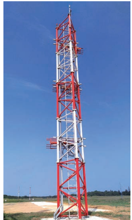
▲ 臺中機場 18 跑道滑降臺 (GP) Taichung Airport's Runway 18 GP
