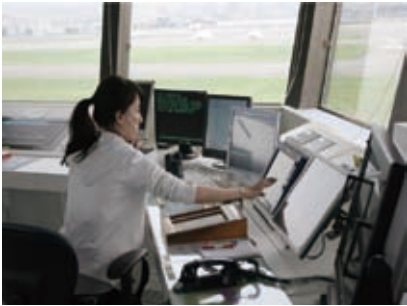
航管自動化系統(松山機場管制臺)
