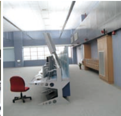
北部飛航服務園航管作業室
