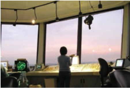
航管自動化系統(臺北機場管制臺)
