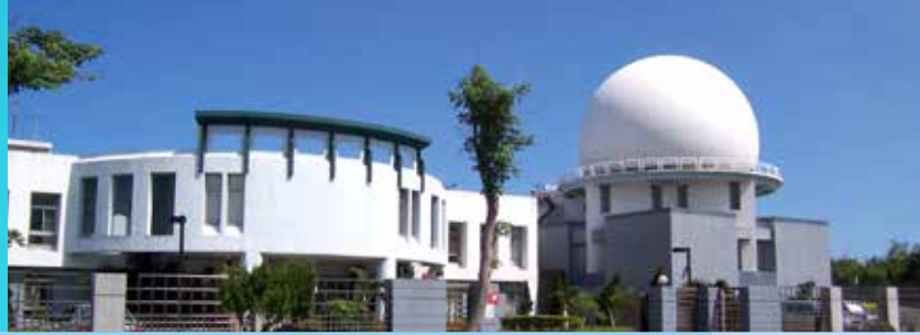
花蓮雷達 Hualien Radar Station
