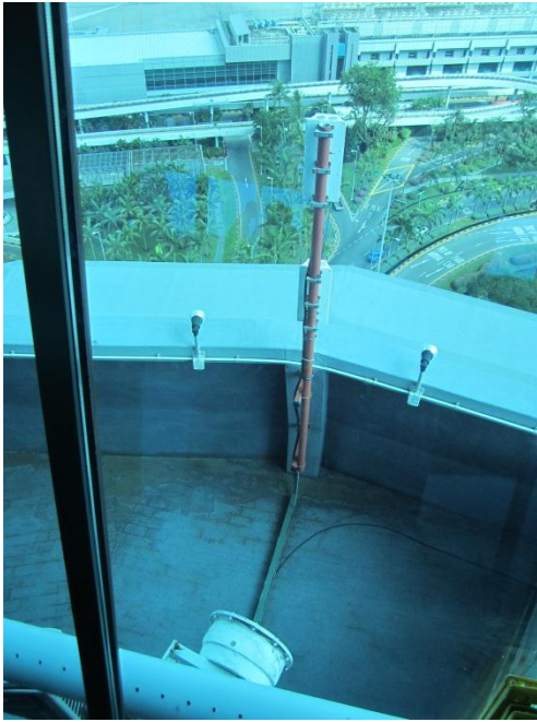
← 多點定位(MLAT)天線架設於 20 樓外部平臺
