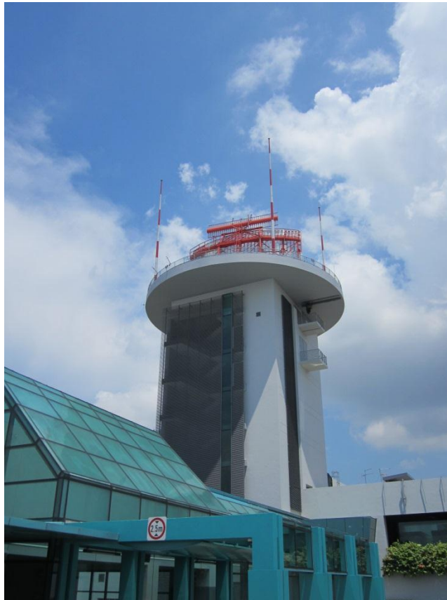
▲位於管制中心之長程雷達，可切換為終端模式使用
