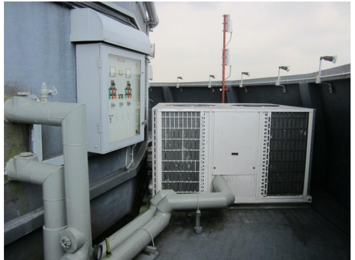
→ 塔臺 20 樓外部平臺可放置大型設備及管線
